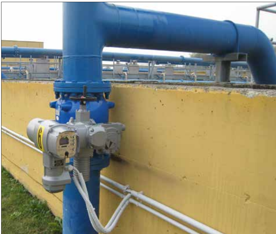
Fig.1 — Valvola a fuso F500 e F560 TIS-AIR per regolazione del flusso di aria all'interno di vasche di nitrificazione.
