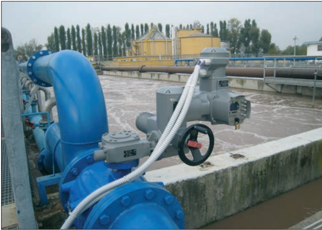
Fig.1, 2 - Valvola a fuso per regolazione del flusso di aria all'interno di vasche di nitrificazione: la valvola è accessoriata con un attuatore elettrico.
