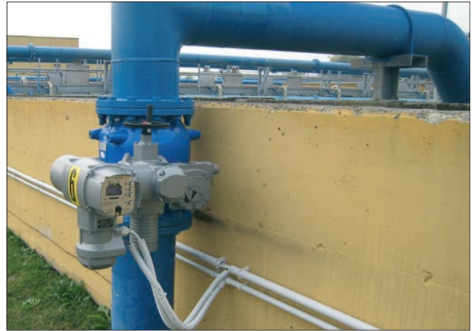
Fig.1, 2 - Valvola a fuso per regolazione del flusso di aria all'interno di vasche di nitrificazione: la valvola è accessoriata con un attuatore elettrico.
